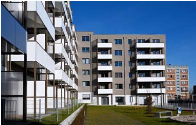
Der begrünte Innenhof des Neubaus Schkeuditzer Straße in Marzahn-Hellersdorf.
