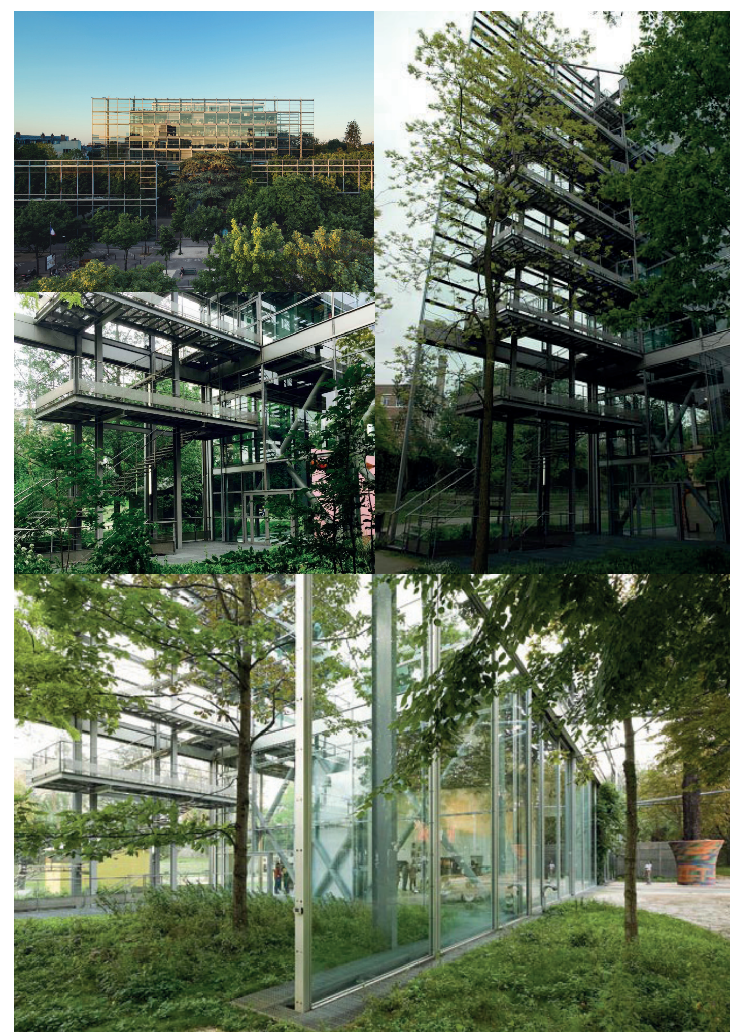
REFERENZ LÄRMSCHUTZWAND - FONDATION CARTIER PARIS, ARCHITEKT JEAN NOUVEL
